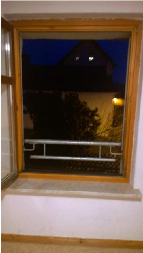
Da die Brüstungshöhe der Fenster im Aufenthaltsraum nicht der HBO entsprechen, wurden dort Geländer angebracht.
