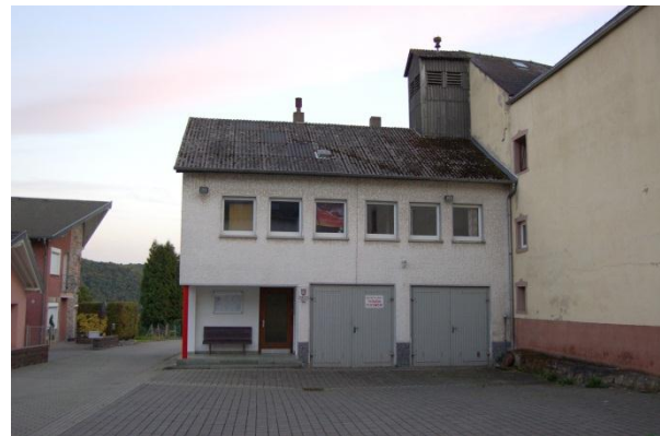
Das Feuerwehrgerätehaus im Dorfzentrum ist sanierungsbedürftig.
