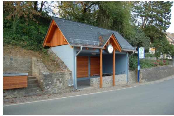
Das „Bushäuschen“ und die angrenzende Milchsammelstelle wurden im Rahmen der Dorfentwicklung und durch ehrenamtliches Engagement saniert.
