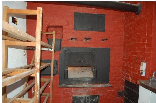
Der Backofen wurde bereits saniert.
