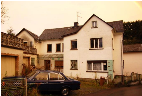
Im Ortskern stehen mehrere Wohngebäude leer.
