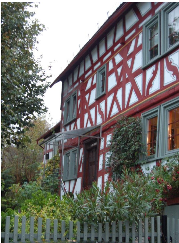
Im Ortskern von Wirbelau gibt es einige gelungene Beispiele für Sanierungsmaßnahmen.
