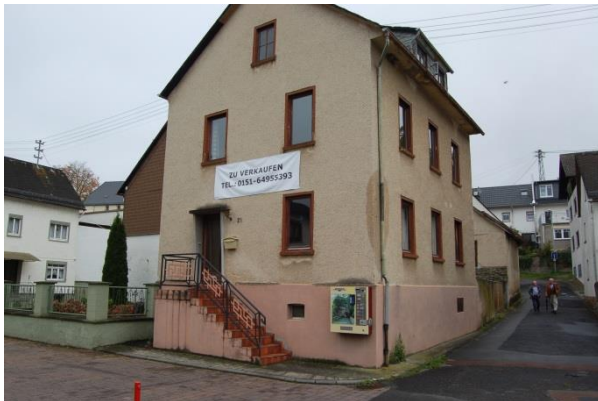
Einer von mehreren Gebäudeleerständen im Ortskern
