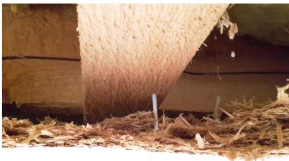
Zum Bild: Die Vernagelung der Verkleidung der Decke weist hier keinen kraftschlüssigen Verbund zur Deckenunterkonstruktion auf.
